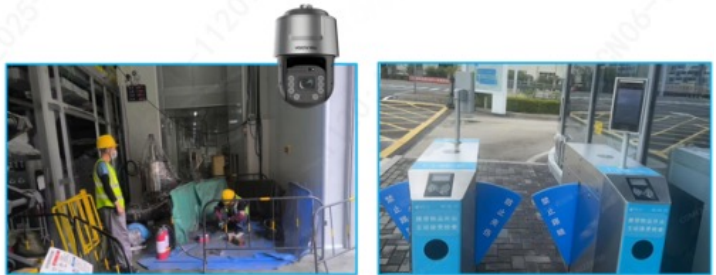
5G摄像头施工现场AI监控
